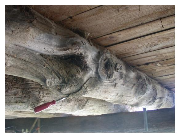
La classificazione strutturale a vista è uno snodo fondamentale dell'intera operazione, perché permette di stimare le tensioni ammissibili degli elementi strutturali, da applicare alle sezioni resistenti residue. Se tutte le operazioni descritte finora richiedono esperienza specifica, questa, ancora più delle altre, richiede personale altamente qualificato.
